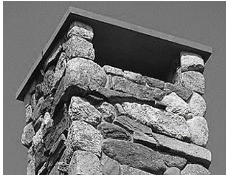
Stone Cap Chimney Top
